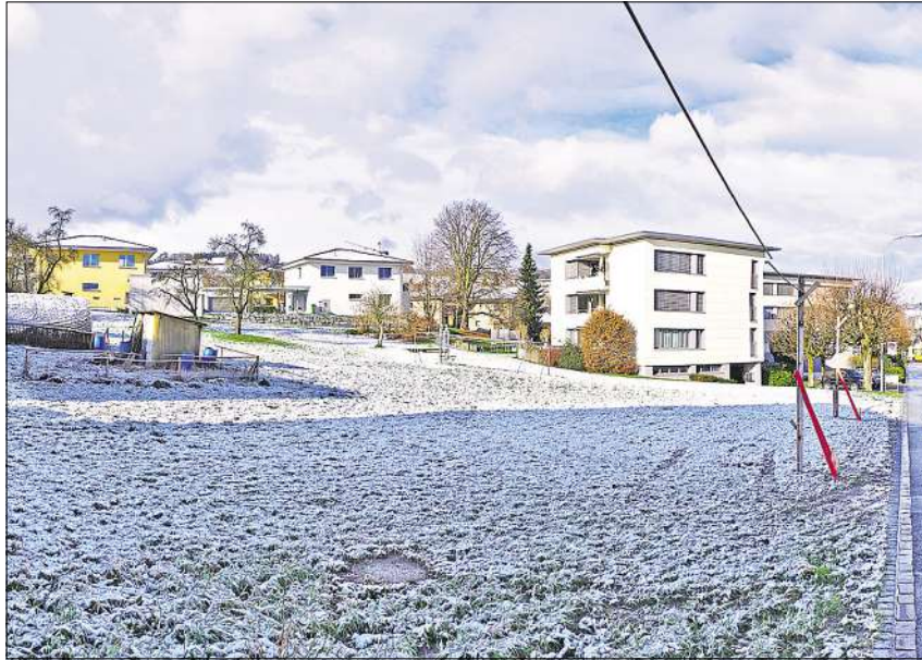
Auf diesem Gelände ist die Überbauung geplant Bild: zVg
