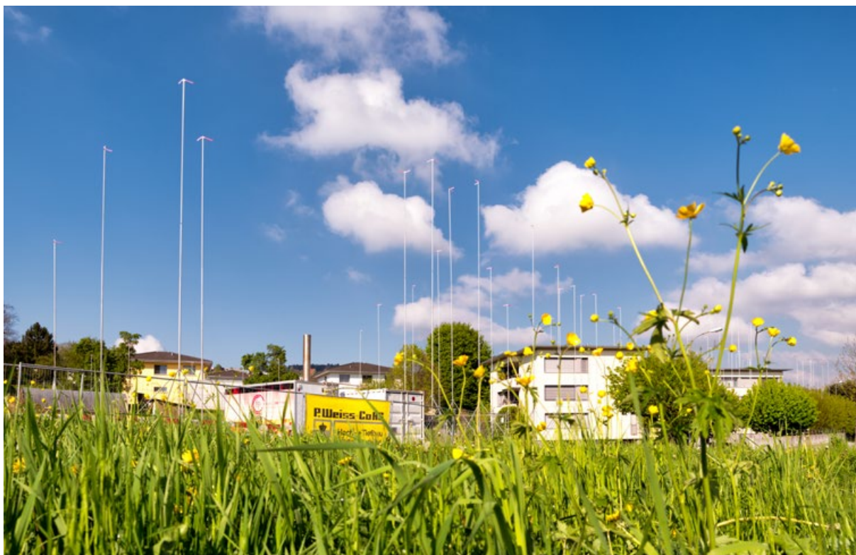
Die Bauprofile sind gesetzt, die Baubewilligung ist erteilt. Das Projekt «Am Chatzebach» ist auf Kurs, geplanter Einzug in die ersten Wohnungen ist im Frühjahr 2019.
